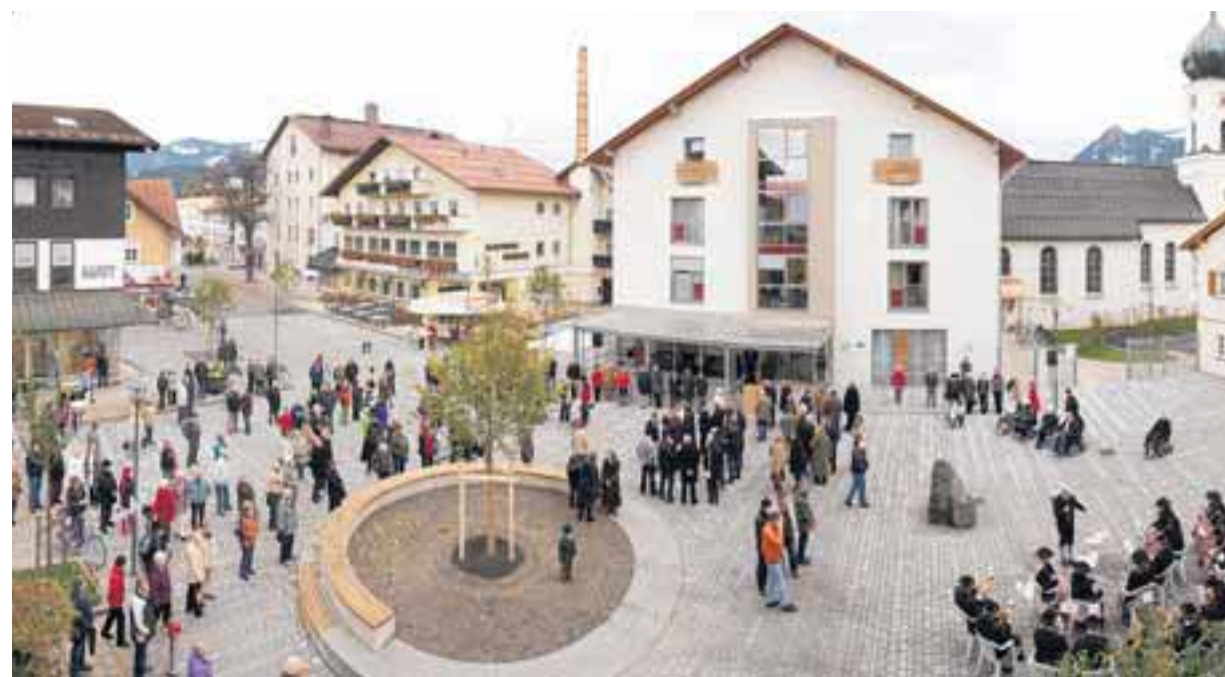
Ein neuer zentraler Platz ist in Sonthofen durch die Erweiterung der Fußgängerzone rund um das umgebaute Spital entstanden. Am Samstag wurde der Bereich seiner Bestimmung übergeben.
